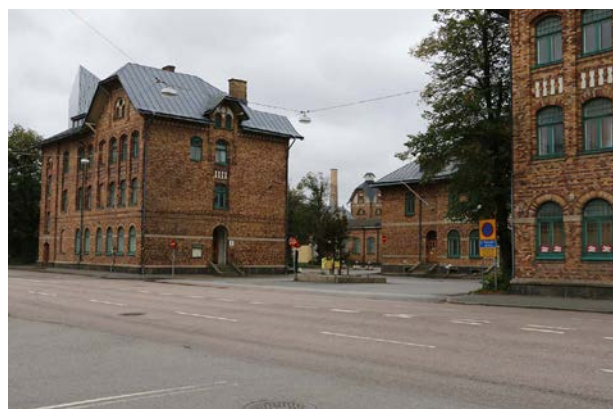
Vy från Slakthusgatan mot gamla huvudentrén. Tornet och skorstenen i fonden.
